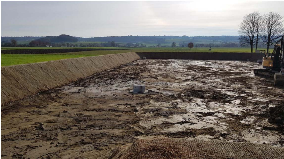
Retention nach Süden
