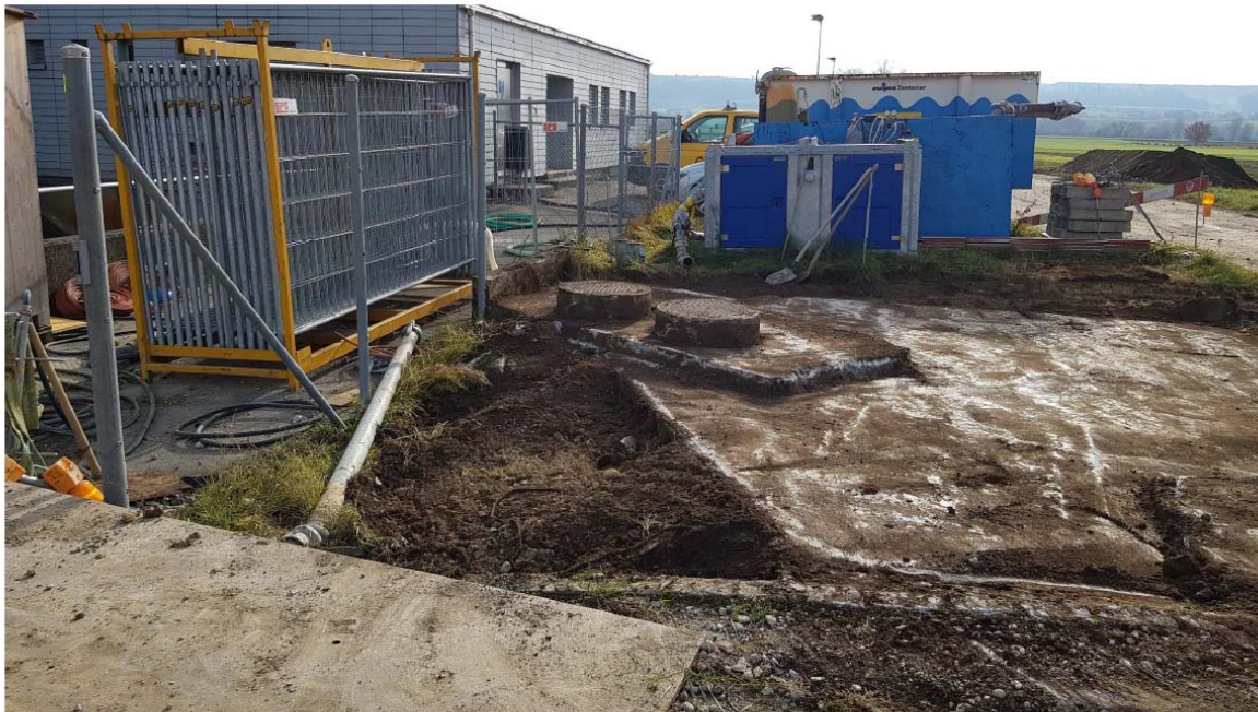
Freilegen bestehendes Zulaufbauwerkes
