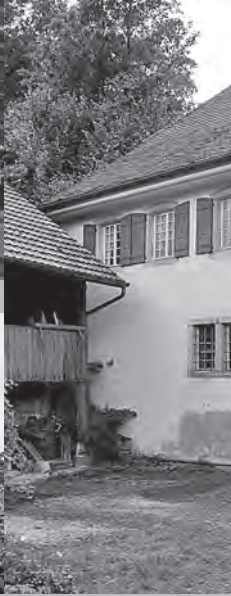
Alte Mühle, Ansicht von Osten
