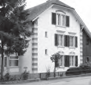
Haus Zilweg 11, Nordansicht
