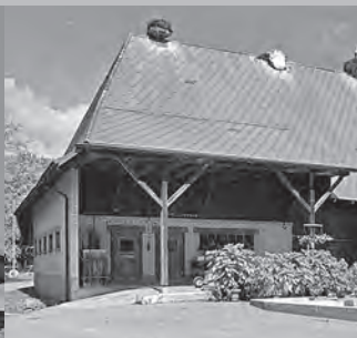
Haus Liechti, Ansicht von Süden
