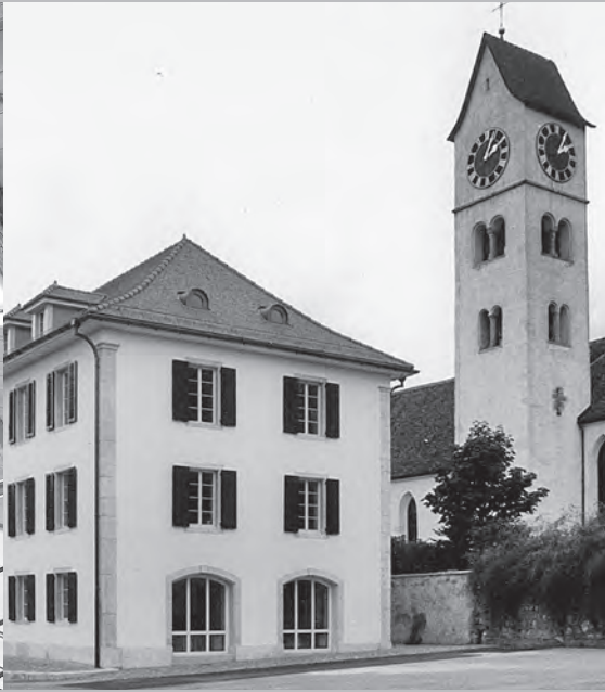
Ansicht von Südosten
