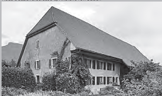
Haus Bellacherstrasse 3, Ansicht von Süden
