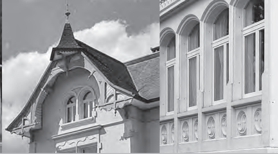
Stähli-Villa, Detail des Giebels und der Fassade
