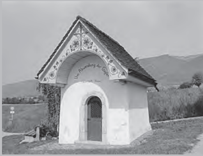
Kapelle Haag, Ansicht von Süden
