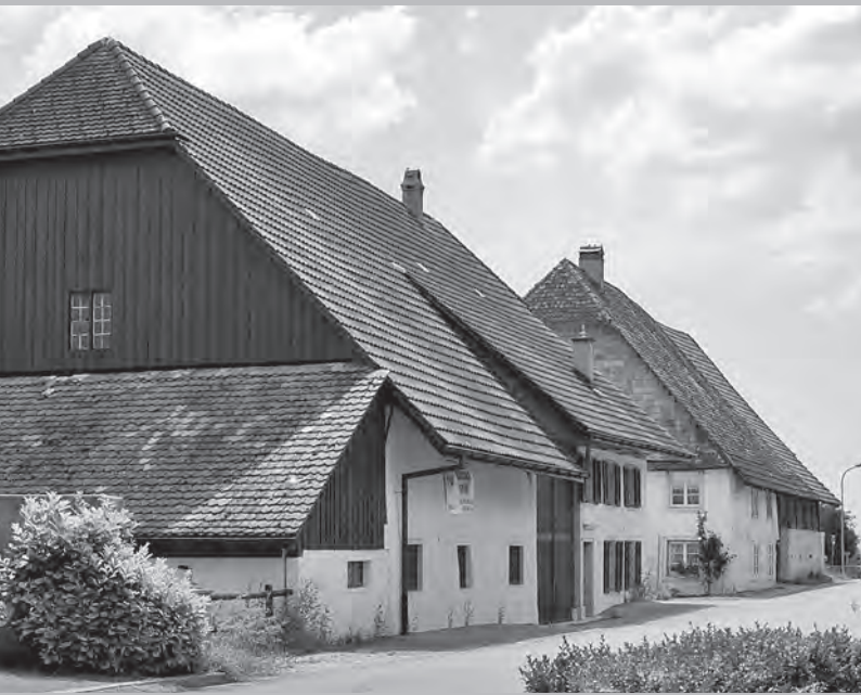
Nordostansicht der Häuser Bettlacherstrasse 3 und 5
