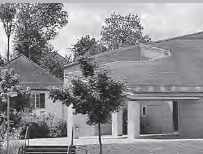
Eingang Pfarreizentrum mit Pfarrhaus
